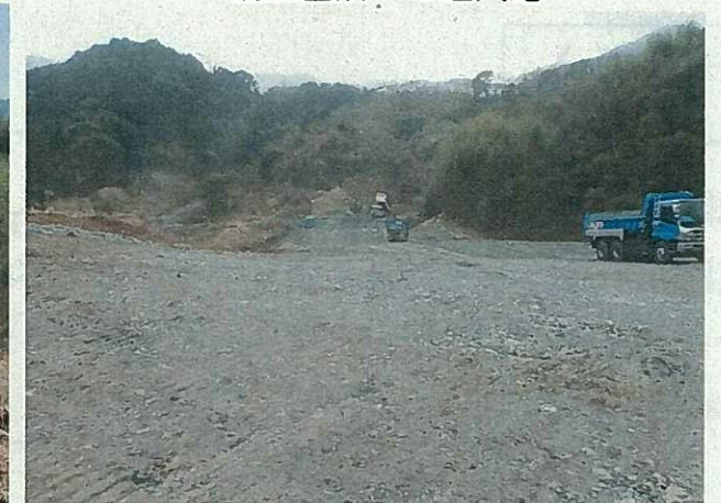
盛土箇所への進入路
